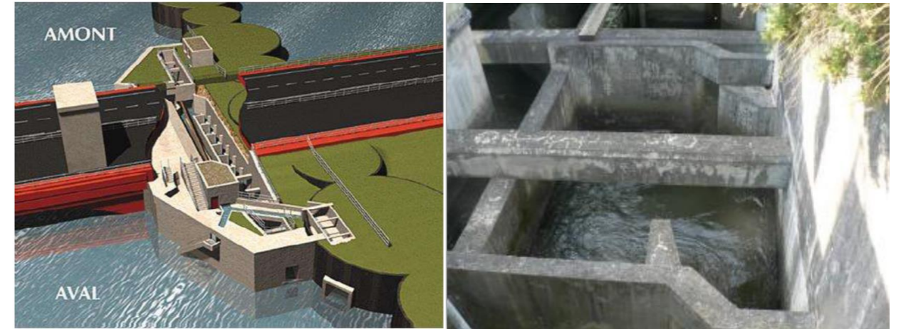
Figure 11 : Vue aérienne des passes construites en 1995 et localisées près des gabions (à gauche) - Photographie d'un des bassins de la passe à poissons (à droite)
