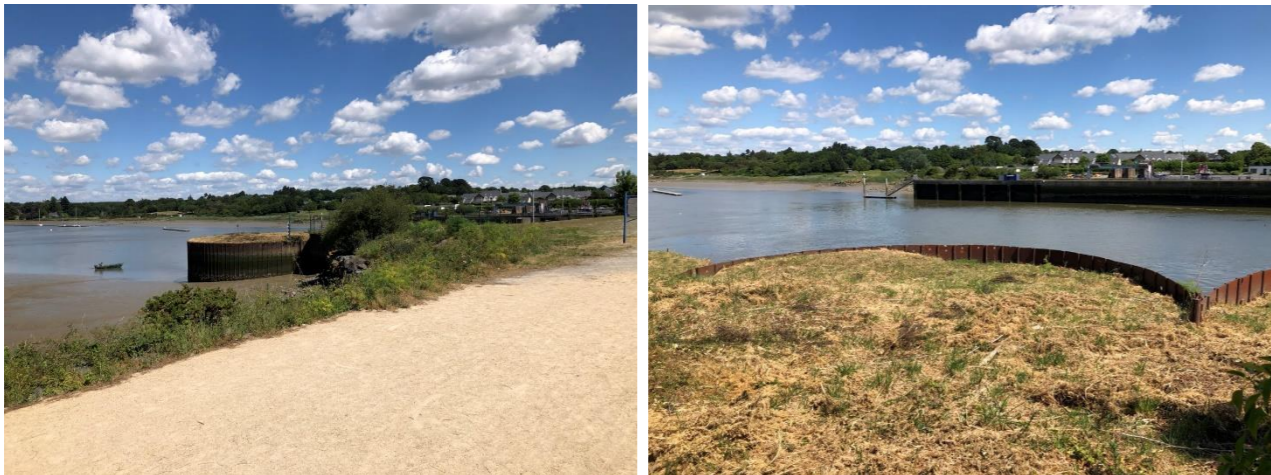
Figure 54 : Végétation sur les gabions aval
